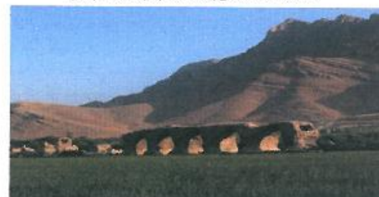
شکل ۲: نمای عمومی پل شکسته (شاپوری - خرم آباد)
